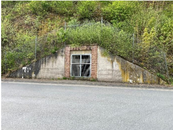
Abbildung 25: Stolleneingang an der Grenze des Geltungsbereichs an der Westendstraße (eigene Aufnahme 29.04.2022)
