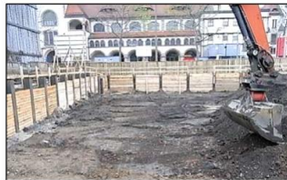
Abb. 4. Schichtenweiser Abtrag, verpflichtend bei baubegleitender KMR
