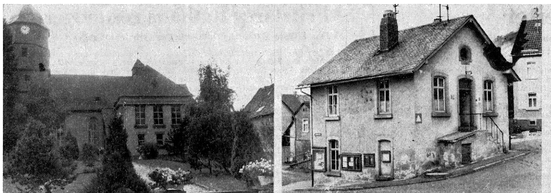
Im Zentrum Dutenhofens steht die alte evangelische Dorfkirche (links) aus dem Jahr 1653. Der Seitenflügel wurde bei der Renovierung im Jahr 1905 angebaut. Die Kirche ist von einer gut gepflegten, blumenreichen Anlage umgeben. — Gegenüber der Dorfkirche liegt das Bürgermeisteramt (rechts). 1867 wurde das Gebäude errichtet. Vor Jahrzehnten diente er als Backhaus. Heute ist es für die Gemeindeverwaltung zu klein geworden. Ein bereits geplantes Mehrzweckhaus soll neuer Sitz der Verwaltung werden.
