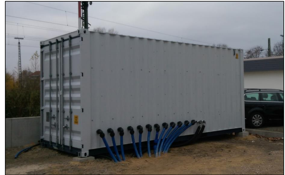
Beispielfoto Wasserreinigungsanlage Breite: 2,5 m, Länge 6,0 m
